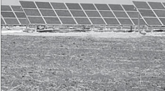
Впервые в России введена в эксплуатацию электростанция с применением альтернативных источников энергии для продажи электроэнергии в сеть. Система состоит из поликристаллических солнечных батарей мощностью 50 кВт и аморфных солнечных панелей такой же мощности. Расчетная производительность данной станции - 133390 кВтч в год.
